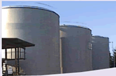
Tank- und Abfüll-Depots
